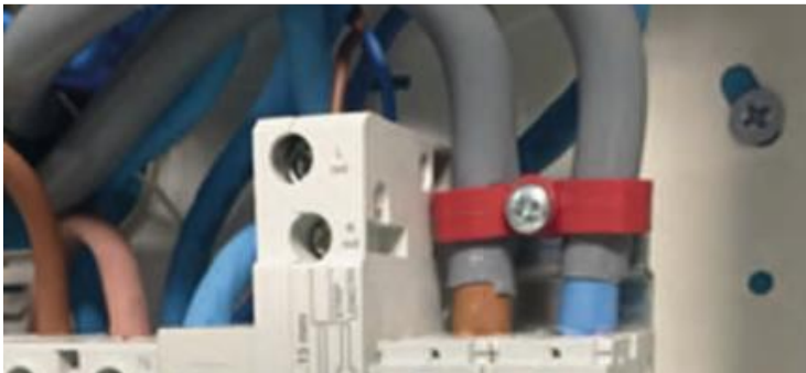
řekil 16. Ana kolon hattının kelepce ile tutturulması örneęi.
