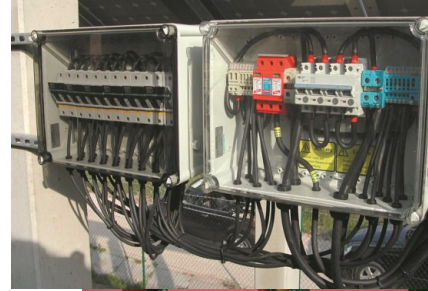
Jeneratör bağlantı kutusu ve toplayıcı kutu
